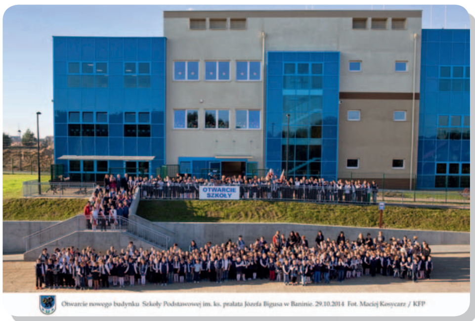
Nowa szkoła przy ul. Tuchomskiej.
