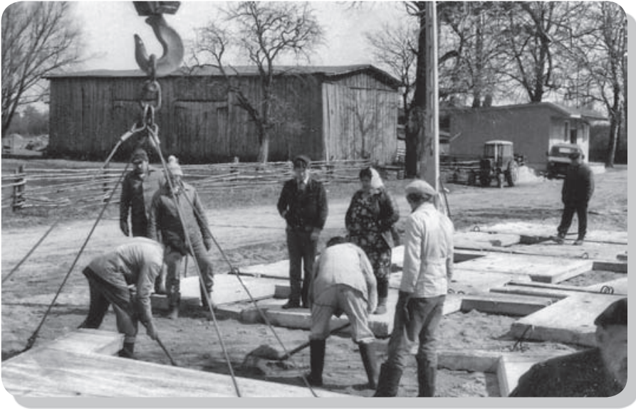
Budowa pętli autobusowej. W środku Albin Bychowski i Brygida Witos.
